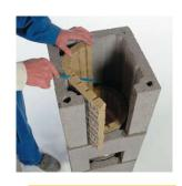
Namestite isečen plašt dimnjaka. Ubacite izolaciju i isecite ispred ventilacionog kanala.
