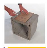
Iscrtajte otvor za vratanca dimnjaka. Širina otvora treba da je 23 cm. Isecite otvor prema linijama po celoj visini plašta.
