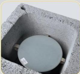
Nakon nanošenja zaptivne mase, postavite zaštitni poklopac na priključak za čišćenje
