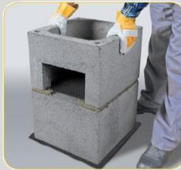
Postavite plašt na sloj maltera i postavite posudu za odvod kondenzata na sredinu postolja. NAPOMENA: U postolju predvideti otvor za povezivanje kondizacione posude sa odvodnom cevi
