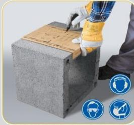
Pomoću šablona ucrtajte na plaštu otvor za ugradnju vratanca dimnjaka i ugaonom brusilicom isecite plašt
