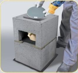
Na kondizacionu posudu postaviti zaštitni poklopac radi sprečavanja ulaska nečistoća pri montaži dimnjaka (u sastavu osnovnog paketa)
