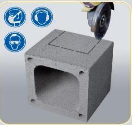
Ugaonom brusilicom izrezati otvor za poklopac odvoda kondenzata dimenzija 23 x 16 cm
