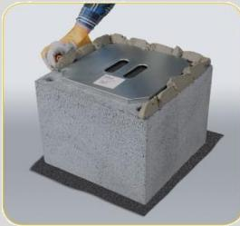
Pomoću metalnog šablona za malter (u sastavu osnovnog paketa) naneti malter na plašt. Za zidanje plašteva, koristiti pripremljenu Schiedel mešavinu maltera
