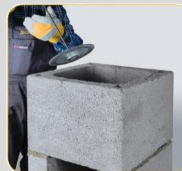
Poravnati spoj priključka za čišćenje i posude za odvod kondenzata korištenjem pomoćnom alatu sa magnetom sa skidačem fuge(uklanja se višak Rotempo mase)
