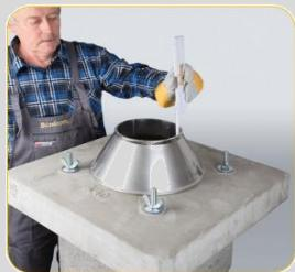
Postaviti krovnu ploču, proveriti horizontalnost, postaviti zaptivne pločice i podloške i pričvrstiti navrtaka sa krilcima (leptir navrtke). Postavite konus na ploču i izmerite visinu radi montaže završne cevi
