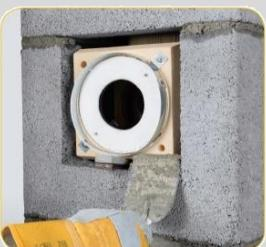
Postaviti priključak na cev i poravnati lice priključka sa dimnjačkim plaštom. Popuniti malterom zazor između sica priključka i plašta
