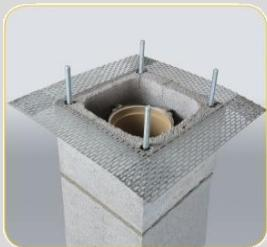
U otvore za armiranje na poslednjem plăštu pre postavljanja krovne ploče, postavite armaturne šipke i zaliјite ih malterom (prethodno zatvoriti otvore u plăštu nepostredno ispod šipki)
