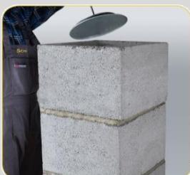
Pomoću držača sa magnetom, uklonite zaštitni poklopac sa priključka za čišćenje
