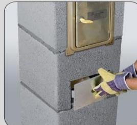
Postavite pokopac odvoda kondenzata na mestu prosecanja prvog plăšta
