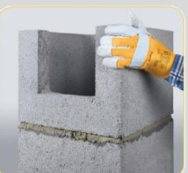
Na mestu ugradnje koaksijalnog priključka ucrtajte otvor  $21 \times 21$  cm i ugaonom brusilicom isecite otvor.
