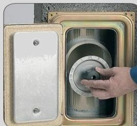
U slučaju priključenja kondenzacionih kotlova (rad u nadprtisku - P 1 ) na dimnjački sistem Quadro PRO, na priključak za čišćenje potrebno je montirati zatvoreni poklopac vratana sa dihtungom i dobro zategnuti
