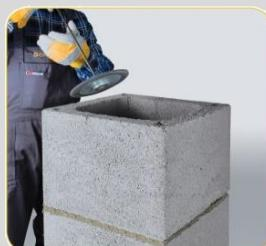
Poravnati spoj priključka za čišćenje i cevi korištenjem pomoćnog alata sa magnetom sa skidačem fuge (uklanja se višak Rotempo mase)
