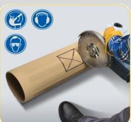
Na cevi dimnjaka, u odnosu na označenu ososvinu, iscrtajte otvor  $11.5 \times 11.5$  cm i brusilicom isecite koristeći rezne ploče za kamen BEZ ZUBA
