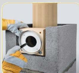
Ubacite cev "na suvo", postavite priključak na cev, iscrtajte osnove priključka i označite osovinu priključka
