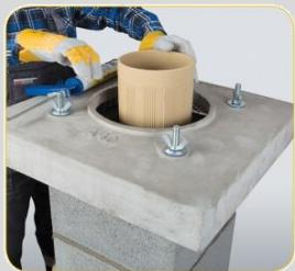
Isecite cev na željenu dužinu brusilicom sa reznom pločom za kamen, nanesite Rotempo masu na žleb donje cevi, očistite i postavite završnu (skraćenu) cev
