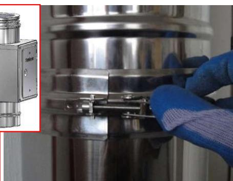
Spajanje elemenata vrši se na jednostavan način pomoću obujmice. Na obujmici se nalazi šraf kojim podešavate potrebnu silu stezanja. Vodite računa da obujmica nalegne na žlebove i da bude dobro stegnuta.
