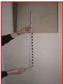
Pre početka montaže provjeriti visinu priključka za ložišta. Visina se određuje osno u odnosu na cev priključka.
