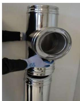
Postavite priključak za ložište. Između revizije i priključka možete montirati dodatnu cev za potrebnu visinu do priključka na ložište.
