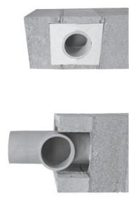
**10** Kolejne czynności przeprowadzamy wg pkt. 8. W przypadku konieczności wykonania dodatkowej rewizji na poddaszu (strychu) montujemy trójnik wykonyując czynności wg. pkt. 4 i pkt. 6. Wejścia mineralna znajdująca się w ostatnim elemencie obudowy, zakonczyć 8 cm ponizej górnej krawędzi pustaka.
