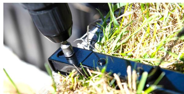
Monter første stigemodul i de nedre brakettene ved å demontere skruen på skjøtelasken, skyve lasken inn i braketten og montere skruen igjen.
