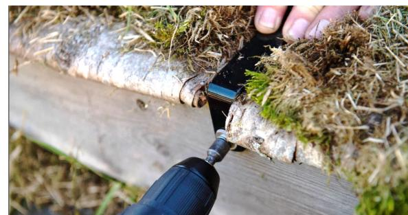
Skru fast vaierbeslaget på torvstokken på motsatt side av taket med skrue 6,3x38mm.
