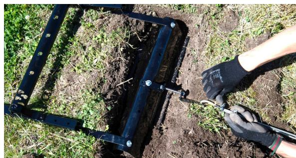
Strekk vaieren, og fest den til strammeskruebeslaget med 2 stk. vaierlåser. Stram til med strammeskruen og påse at vaieren er stram.
