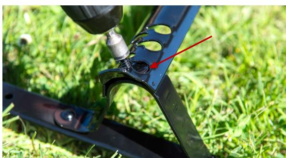
Monter tverrtrinnene over de påmonterte skruene. NB! Sjekk at materialforskyvningen synes i det store hullet. Skru godt fast slik at du kan gå i stigen når du monterer deg opp mot mønet.
