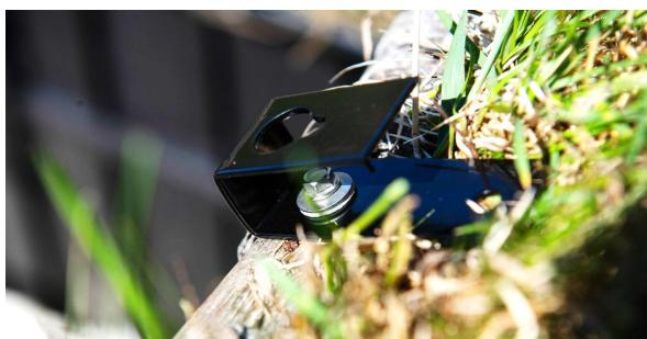
Monter de to nedre innfestebrakettene på torvstokken med én skrue på hver, 6,3x38mm.
