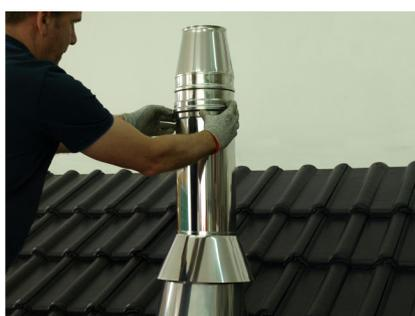
17. Installare il terminale e fissarlo con la fascetta stringitubo.
