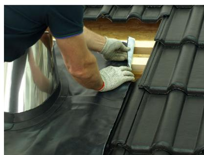
9. Pieghere il bordo laterale della membrana fino a formare una barriera drenante.
