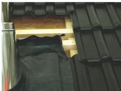
10. Piegare la membrana verso l'alto per formare una barriera per impedire la penetrazione dell'acqua nella struttura del tetto.
