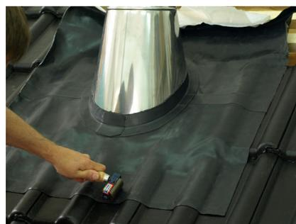
6. Usare il rullo premendo la guaina del faldale Wakaflex sulle tegole per garantire una connessione salda.
