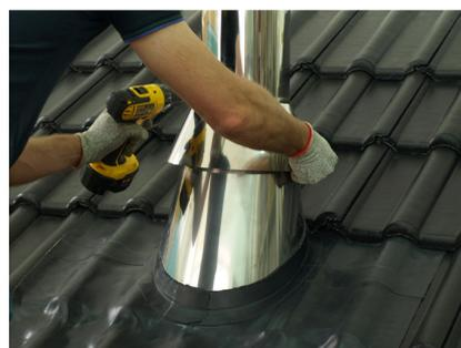
15. Installare la fascia anti intemperie e serrare la vite per ancorala saldamente alla canna fumaria.
