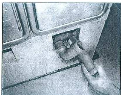
Inserire il sifone dn 40 all'interno della base di partenza e ruotarlo allacciandolo all'adattatore e allo scarico condensa
