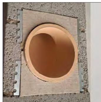
31. ...majd a csatlakozó köré betesszük. Figyelem! Az előlapot a vakolás előtt a helyére kell tenni, így a bekötő csomak szépen körbedolgozható.
