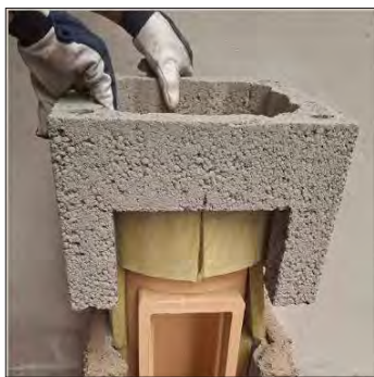
13. Elhelyezzük a szigetelő lapokat és a kivágott köpenytéglát a helyére tesszük.
