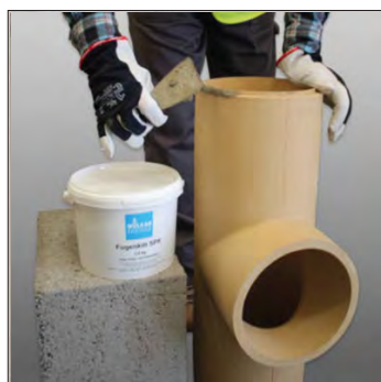
25. Samotragasztót hordunk fel a füstcső-csatlakozó peremére.
