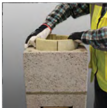
19. ...hőszigetelő lapok behelyezése, a köpenytéglára habarcsréteg, illetve a (33 cm-es magasságú) samottcső peremére a samotttragasztó felhordása ...
