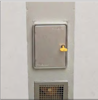
48. Az ajtó rögzítő kerete bevakolható a kémény többi részével együtt. Ezután a szellőzőrácsot is be tudjuk tenni a helyére.
