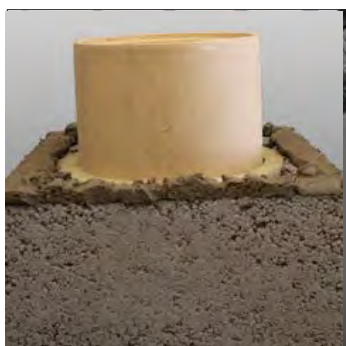
32. A füstcső-csatlakozó után haladjunk a normál építési sorrenddel egészen a tetőig.
