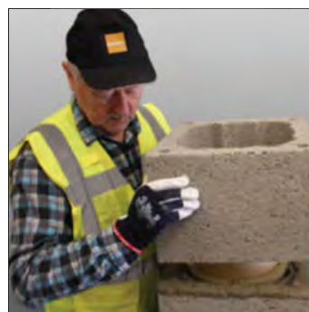
35. Ezután haladjunk a normál építési sorrenddel egészen a torkolati magasságig.
