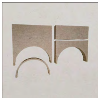
30. Az ásványgapot előlapot a megfelelő méretre igazítjuk.
