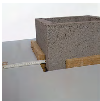
33. A födémáttörés minden min. 3 cm-rel nagyobb legyen, mint a köpenytégla külső méretei. Éghető anyagtól való távolság: min. 5 cm! A hézagot nem éghető szigetelő anyaggal kell kitölteni.
