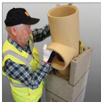
26. A ragasztós felével lefelé a helyére illesztjük és a kinyomódó hézagkitett nedves szivaccsal letöltjük.
