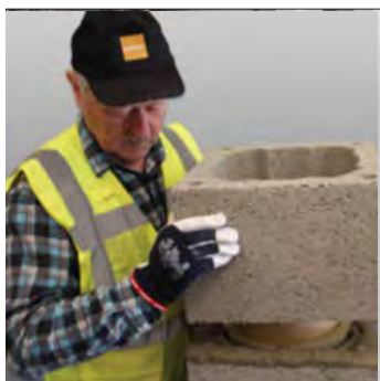
18. Az építési sorrend ezután: következő köpenytégla elhelyezése...,
