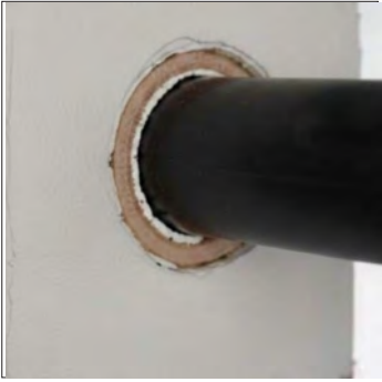
50. A fellépő hőtágulásnak helyet kell hagyni. A hőtágulás lehetőségét biztosító elasztikus anyaggal kell a rést kitölteni (pl.: keramikus zsinór).
