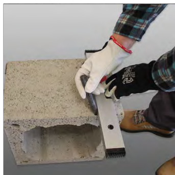
23. A füstcső csatlakozó elhelyezése előtt vágjuk ki a köpenytéglát. A 18-as és 20-as beslő átmérőjű kéményeknél 25 cm széles legyen a kivágás. (16-os kémény-átmérőnél: 21 cm)
