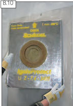
Az IGNIS PROTECT-et illessze a helyére. Az alumínium kasírozott bevonatú oldal legyen belül.
