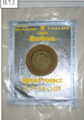
Kész nézet a körkörös, szorosan beragasztott párazáró fóliáról a helyére illesztett, IGNIS PROTECT elemmel együtt.
