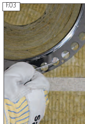
Rögzítse az esőgallért rozsdamentes acél szögekkel (nem szett tartozék).
