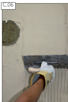
Rétegvastagság kialakítása fogazott simítóval.
