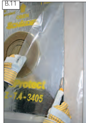
Vágja a pontos méretre a helyszíni párazáró fóliát az IGNIS PROTECT széleinek segítségével.
