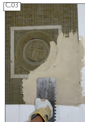
A réskitöltő ágyazó habarcsot csak az IGNIS PROTECT külső részére hordja fel. Semmiképpen se dolgozza rá a csőhéjakra!
