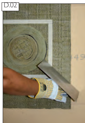
Ellenőrizze, hogy a helyszíni hőszigetelés síkban van-e.
