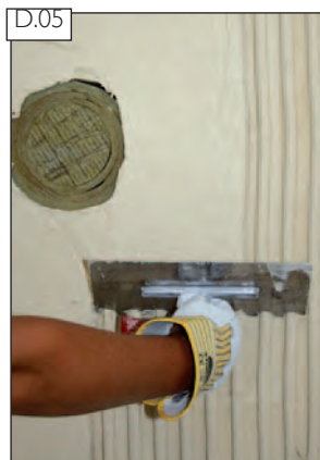
Rétegvastagság kialakítása fogazott simítóval.
