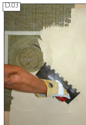
Hordja fel a habarcsot. Figyelem! Az anyagot csak az IGNIS PROTECT külső részére kenje fel. Semmiképpen se dolgozza rá a csőhéjakra!
