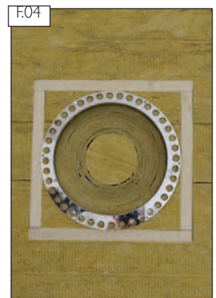
Az ágyazó habarcs felhordása előtt ismét ellenőrizze, hogy az esőgallér központosan van-e a helyén.
