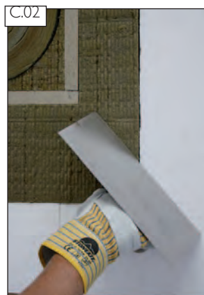
Ellenőrizze, hogy a helyszíni hőszigetelés síkban van-e.
