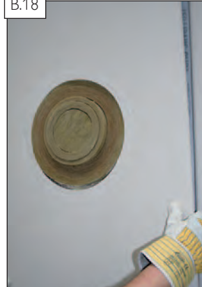
Helyezze vissza a kivágott gipszkartont. FIGYELEM! A párazáró fólia nem sérülhet meg!
