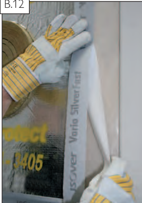
A párazáró fólia szélénél zárja össze a rést megfelelő tömítőszalag alkalmazásával a szalagot az alumínium kasírozott felületre ragasztva.
