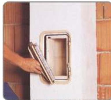
**48** Kad je dimnjak ožbukan, postavite unutarnji uložak dimnjačkih vratašca.
