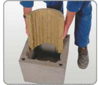
**14** Izolacijsku ploču savijte i stavite u plašt dimnjaka.
