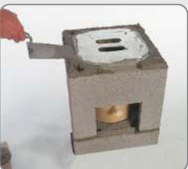
7 Kod nanošenja morta upotrebljavajte šablonu za zidanje. Ona sprječava padanje morta u unutrašnjost plašta dimnjaka.
