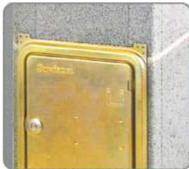
**47** Nakon montaže vratašca dimnjak možete ožbukati.
