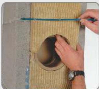
**40** Izrežite otvor za priključak na prednjoj izolacijskoj ploči prema utoru.
