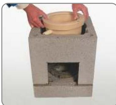
4 Posudu za kondenzat uložite u sredinu prvog plašta dimnjaka na pripremljenu podlogu.
