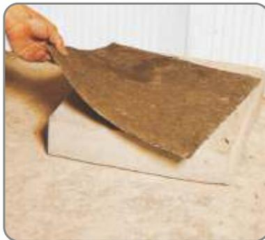
1 Na pripremljenu podlogu postaviti ploču od hidroizolacijskog materijala. Nije sastavni dio seta, sami pripremate podlogu.
