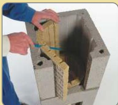
9 Postavite izrezani plašt, namjestite izolaciju te je izrežite ispred kanala za provjetranje dimnjaka.
