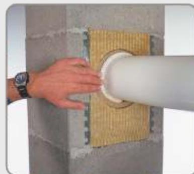
**42** Međuprostor između priključka i priključne cijevi zabrtvite odgovarajućim (keramičkim) užetom.
