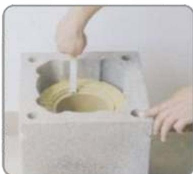
**37** Izolacijska ploča i cijev kod zadnjeg plašta završavaju 7 - 10 cm od ruba plašta
