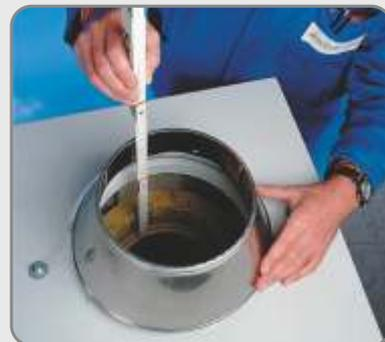
31 Izmjerite potrebnu visinu zadnje cijevi.
