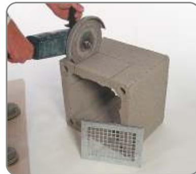
2 Na prvom plaštu označite i izrežite otvor za ventilacijsku rešetku.
