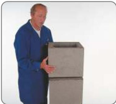
24 Postavite sljedeći plašt i provjerite vertikalnost.
