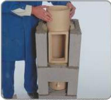
**12** Priljučak za vratašca okrenite i uložite u plašt dimnjaka. Nastavak za vratašca mora biti u ravni s plaštem.
