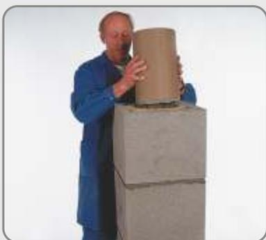
27 Okrenite i namjestite cijev u plaštu i tim postupcima nastavite do završetka dimnjaka.
