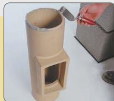
11 Rubove priključka za vratašca očistite i navlažite spužvom. Nanesite Schiedel kit na donji dio priključka za vratašca ("muški dio").
