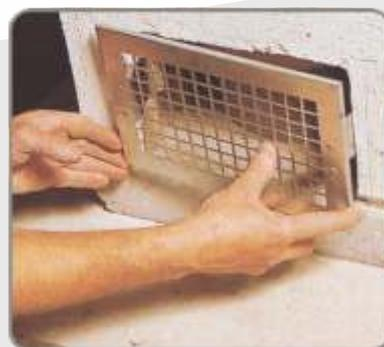
**51** U izrezani otvor na prvom plaštu namjestite rešetku za ventilaciju.
