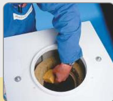
34 Očistite i navlažite rub već ugrađene cijevi.
