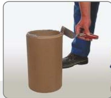
26 Rubove cijevi očistite i navlažite spužvom. Schiedel kin nanesite na donji dio cijevi ("muški dio").
