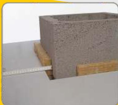
**43** Otvor na ploči mora biti kod svih stranica za 3 cm veći od plašta.
