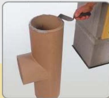
**22** Rubove priljučka za ložište očistite i navlažite spužvom. Nanesite Schiedel kit na donji dio priljučka za ložište ("muški dio").
