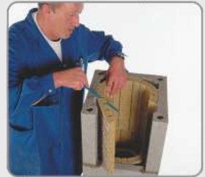
**20** Postavite izolacijsku ploču. Prednji kanali za provjetranje moraju ostati slobodni.
