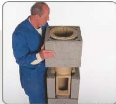
**16** Postavite sljedeći plašt i provjerite vertikalnost.
