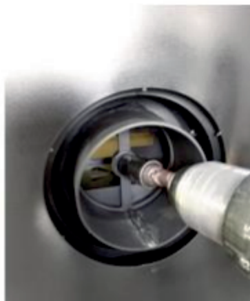
Učvršćivanje priključne mlaznice za zrak vijkom M8
