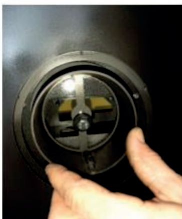
Sastavljanje mlaznice klima uređaja
