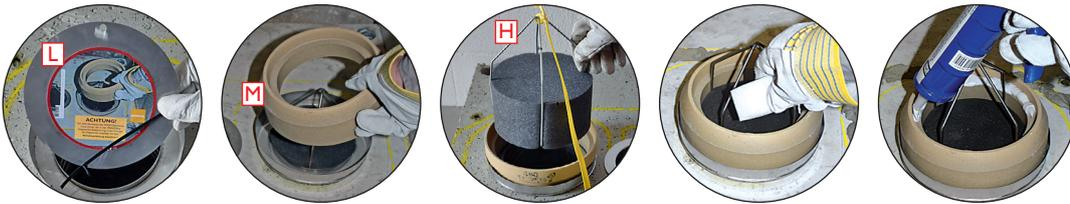
Metallschild mit Hinweisaufkleber (**L**) entfernen, Adapterring in Trichter einlegen (**M**), Versetzhilfe (**H**) einbringen, Muffenverbindung des Adapterringes säubern und Klebemörtel RAPID-fugendicht gleichmäßig auftragen.
