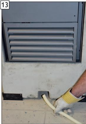
Verlegen der bauseitig erforderlichen Leerrohrverbindung vom KINGFIRE CLASSICO S zum bauseitigen Elektroschrank/ Kleinverteileranlage.
