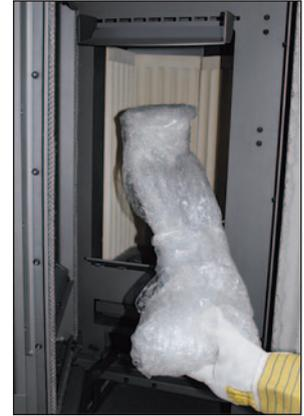
Sichtschutzblende für Konvektionsluftgitter (schwarz - Art.-Nr.: 170758) (grau - Art.-Nr.: 148525) aus der Brennraum herausnehmen und bis zur Montage aufbewahren.
