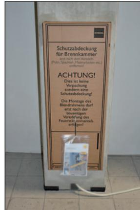
3. Die werkseitige Schutzabdeckung bis zum Abschluss der bauseitigen Veredelungsarbeiten (Putz- und Malerarbeiten) nicht entfernen!
