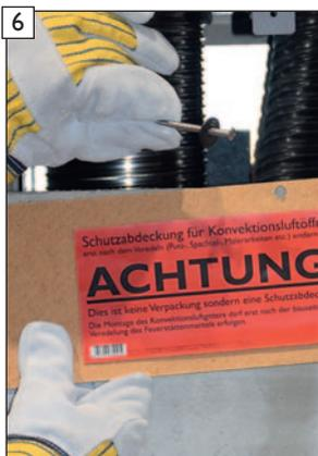
6 Schutzabdeckung entfernen. **HINWEIS!** Die Beilagscheibe zur Sicherung der Schutzabdeckung wird für die weitere Montage nicht mehr benötigt!
