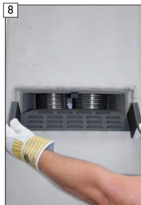
8 Sichtschutzblende schräg angestellt in die Konvektionsluftöffnung einstecken und dann bis zum Anschlag nach unten schieben.
