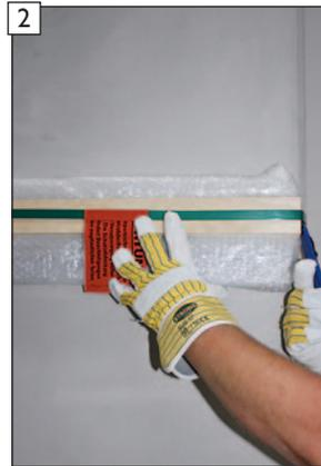
2 Transportschutzverpackung öffnen. **WICHTIG!** Beschädigungen am Konvektionsluftgitter/Lackierung vermeiden!
