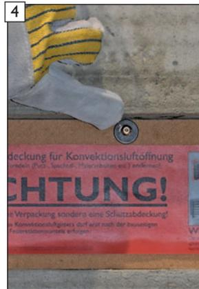
4 Detailansicht mit werkseitig eingedrehter Inbus-Sicherungsschraube für Konvektionsluftgitter.
