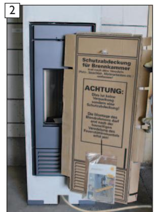
Werkseitige Schutzabdeckung entfernen.
