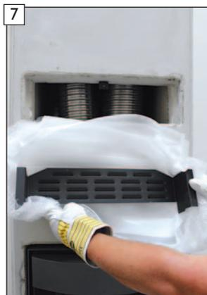
7 Sichtschutzblende auspacken. **WICHTIG!** Beschädigungen an der Sichtschutzblende/Lackierung vermeiden!
