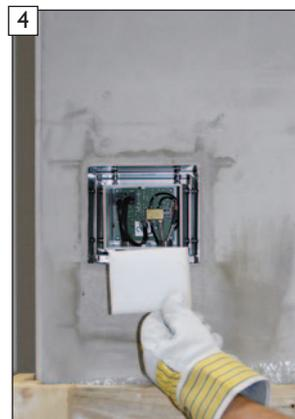
4 Schutzschwamm entfernen.
