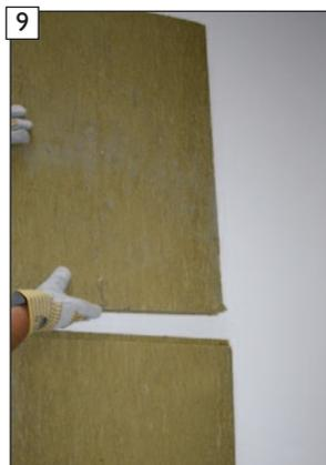
9 Obere Nutplatte in die Doppelfederplatte einstecken.
