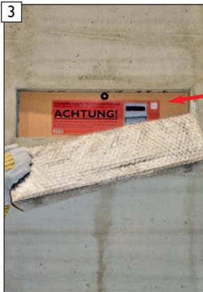
3 Konvektionsluftgitter aus der Montageöffnung entfernen.
