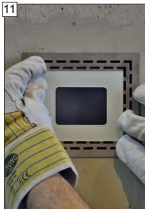
... in Displayblende bzw. der Bedien- und Messeinheit einrasten.
