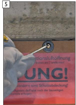
5 Inbus-Sicherungsschraube für Konvektionsluftgitter herausschrauben.
