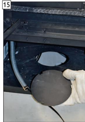
Revisionsdeckel am Gehäuseboden der Brennkammer herausnehmen.
