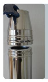
Mündungsabschluss versetzen und mit Klemmband kraftschlüssig verschrauben.
