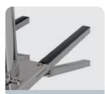
10. Erforderliche Länge der Regenabdeckung ermitteln (von der fertigen Putzoberkante der Wand bis zur Wandkonsole), abschneiden und einsetzen.
