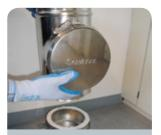
Putztüranschluss auf die Grundplatte bzw. den Fußteil versetzen.
