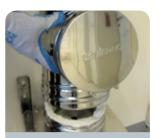
Putztüranschluss auf die Grundplatte versetzen.
