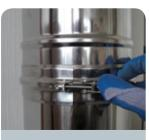
3. Rohrelement versetzen. Klemmband am Rohrelement über die Sicke der Stoßverbindung schließen und kraftschlüssig verschrauben.
