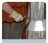
5. Regenkragen oberhalb der Dachdurchführung am Rohrelement versetzen und kraftschlüssig verschrauben. Weiter bis zum letzten Rohrelement. ACHTUNG: max. Höhen über Dach beachten (siehe Planungshinweise).
