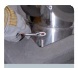
Grundplatte am bauseitig erstellten Fundament befestigen. Weiterer Versetzvorgang siehe Putztüranschlüsse Seite I 3.
