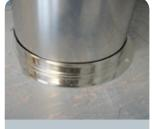
Fußteil am bauseitig erstellten Fundament befestigen. Weiterer Versetzvorgang siehe Putztüranschlüsse Seite
