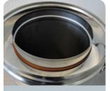
Bei Überdruckanlagen Dichtring über die Sicke des inneren Rohres spannen
