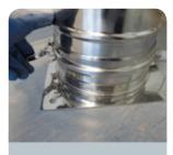
Klemmband über die Sicke schließen und kraftschlüssig verschrauben. Das Klemmband des Putztüranschlusses bleibt übrig!
