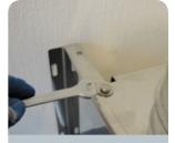
5. Grundplatte nun kraftschlüssig mit Konsolblech verschrauben. Weiterer Versetzvorgang siehe Putztüranschlüsse Seite 13.
