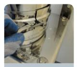
Klemmband über die Sicke schließen und kraftschlüssig verschrauben.
