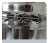
3. Sicherungsseil der Regenhaube am Verschluss des Klemmbandes befestigen.
