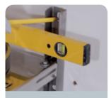
Bohrlöcher markieren und herstellen. Auf waagrechte Ausrichtung achten und gemäß nachstehendem Hinweis auf die massive Wand montieren.
