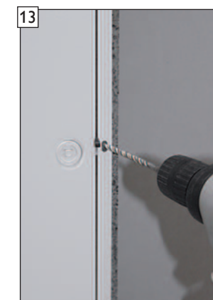
13 Teprve nyní, v druhém kroku, připravte dva centrálně vyvrtané otvory.
