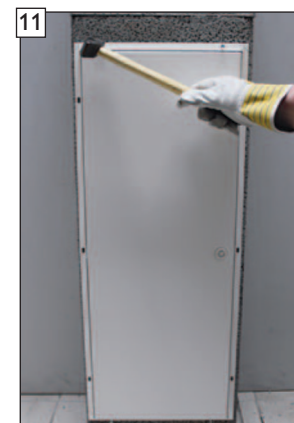
11 Vložte hmoždinky do dvou horních a spodních upevňovacích otvorů a zatlučte je do paty.
