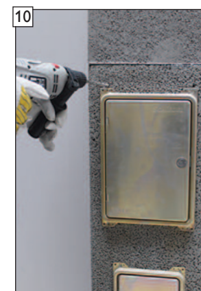
10 Nejprve předvrtejte pouze dva horní a spodní montážní otvory.
