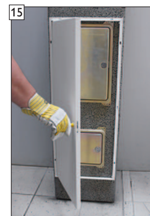
15 Odstraňte plastové klínky a proveďte kontrolu funkčnosti dvířek.
