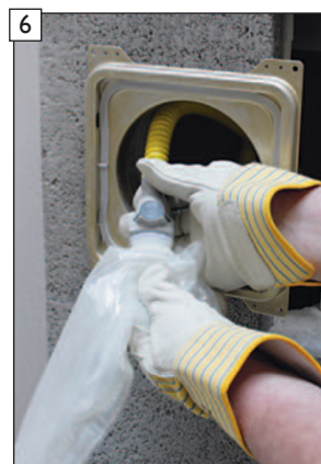
6 Připojte sáček na sběr kondenzátu ke spojovací části.
