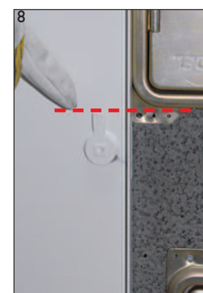
8 Důležité! Uzavírací páčka v křídle dvířek nesmí být umístěna příliš vysoko, aby nenarážela do omítkového rámu.
