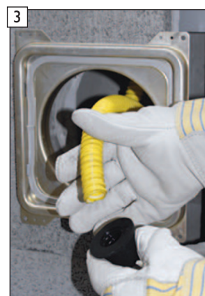
3 Odšroubujte adaptér pro připojení HT potrubí DN 40 ze sifonové hadice.
