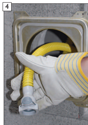
4 Nasuňte spojovací část sáčku na sběr kondenzátu na 3/4" hadici sifónu.
