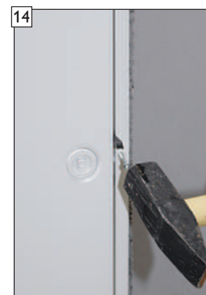
14 Vložte a zatlučte hmoždinku. POZOR! Dávejte pozor, abyste nepoškodili lak.
