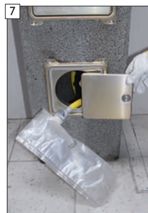
7 Výměna panelu dvířek za dvířka bez otvoru
