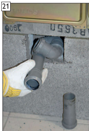
Zašroubujte část sifonu HT a připevněte ji k připojení adaptéru PA tvarovky.
