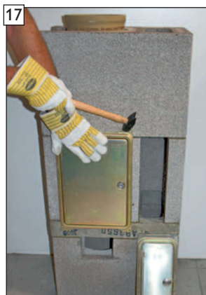
Připevněte čisticí dvířka (volitelné kontrolní dvířka).
