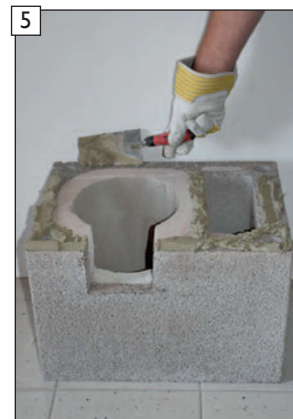
Na první tvárnici naneste tenkovrstvovou maltu. DŮLEŽITÉ! Také v oblasti šachty a v rozích tvárnice!
