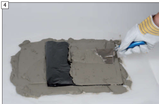
- Připravte maltové lože MG (M5) IIa (maltová malta podle EN 998-2) - Vložte izolaci proti vlhkosti - Naneste maltové lože MG (M5) IIa (maltová malta podle EN 998-2) - První tvárnici nebo izolační dělicí prvek položte do lůžka a vyrovnejte.
