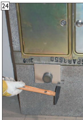
... upevněte jej hřebíky do betonu.
