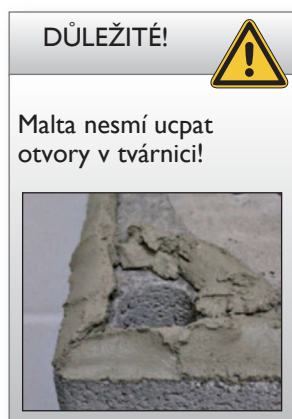
- Připravte maltové lože MG (M5) IIa (maltová malta podle EN 998-2) - Vložte izolaci proti vlhkosti - Naneste maltové lože MG (M5) IIa (maltová malta podle EN 998-2) - První tvárnici nebo izolační dělicí prvek položte do lůžka a vyrovnejte.
