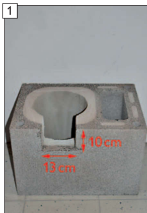
Požadované rozměry otvoru : šířka 13 cm a výška 10 cm
