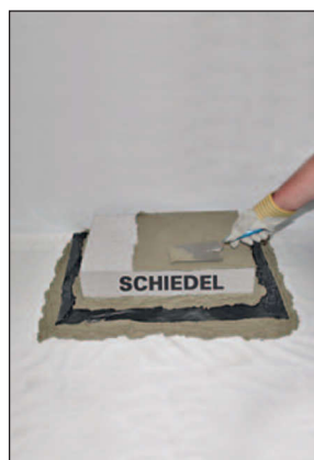
Následně naneste další maltové lože na izolační dělicí prvek (není součástí dodávky, objednávejte zvlášť).
