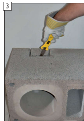
Vyřízněte tepelnou izolaci pilou na izolaci.
