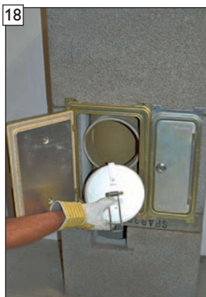
Vložte uzávěr dvířkového kusu. (Ilustrace na příkladu kontrolního uzávěru „F“ na pevná paliva).
