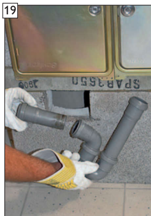
Sejměte přední část potrubí HT.
