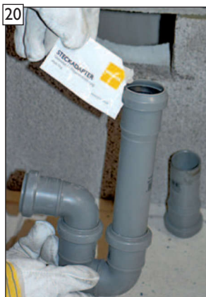
Na horní a dolní část naneste mazivo.
