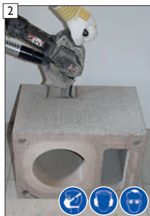
Vyřízněte otvor. POZOR! Dodržujte bezpečnostní pokyny bezpečnosti práce na straně 2!
