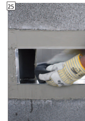
Odstraňte přebytečnou maltu a očistěte kovové části od malty.
