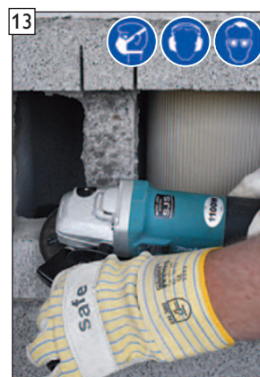
V případě potřeby zarovnejte případné nerovnosti na oříznutých hranách. POZOR! Max. hloubka řezu 70 mm!
