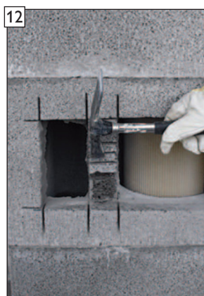
Opatrně odklepte a odstraňte vyříznuté segmenty.
