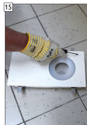
Vyšroubujte upevňovací šrouby panelu adaptéru přívodu vzduchu LAS.
