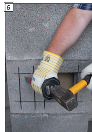
Malým dlátem opatrně odstraňte první vrstvu komínové tvárnice v oblasti průduchu.
