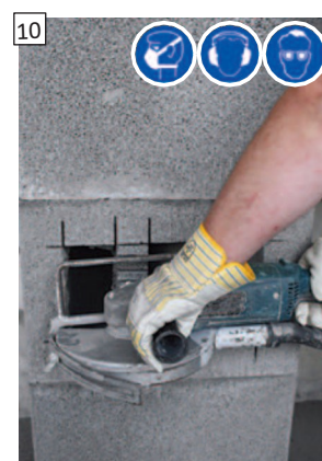
Provedte řezy dělicí části na komínové tvárnici POZOR! Hloubka řezu max. 70 mm!
