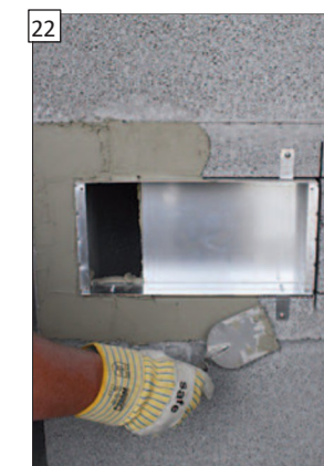
Rám zamaltujte a spojte těsně s tvárnici maltou MG (M5) Ila (zdicí malta podle EN 998-2).
