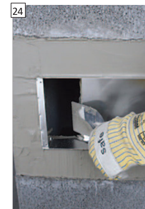
Přechod také důkladně zamaltujte.
