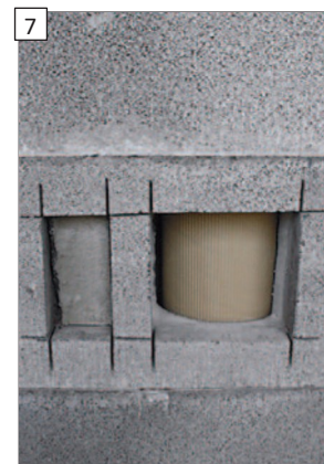
Pohled na hotové otvory.
