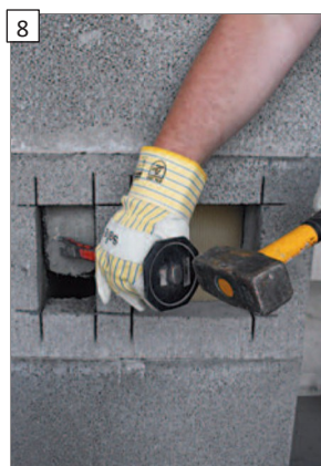
Druhou vrstvu tvárnice opatrně odstraňte malým dlátem.
