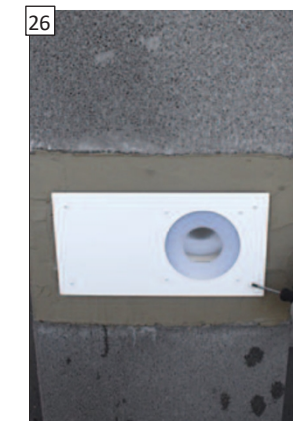
Přišroubujte kryt na rám. POZOR! Nepoškodte těsnění!
