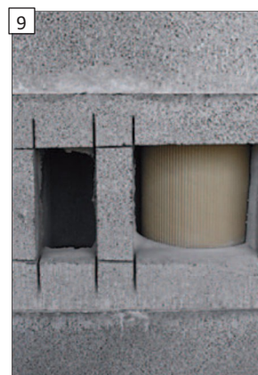
Případné nerovnosti na oříznutých hranách v případě potřeby znovu opracujte.
