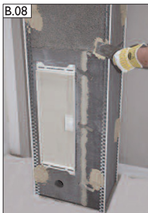
Připevnění omítkových rohů.
