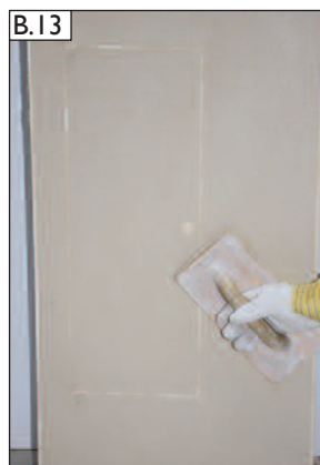
... současně očistěte ochrannou těsnicí vrstvu.
