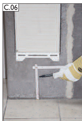
C.06 Na místě si určete požadovanou stranu a rozměry otvoru.
