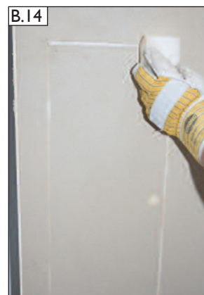
Ochrannou těsnicí vrstvu očistěte houbou.
