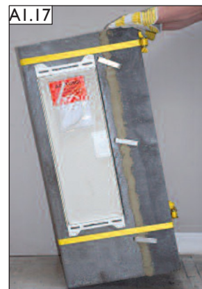
Hotovou patu je nyní možné okamžitě položit do připraveného maltového lůžka.
