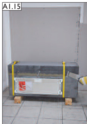
Spoj na přední a zadní straně dokončete vytmelením maltou.
