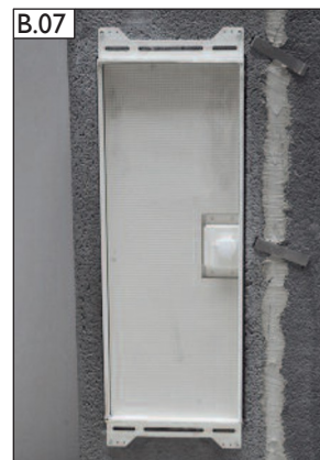
Hotový pohled s kompletně nainstalovaným ochranným těsněním.
