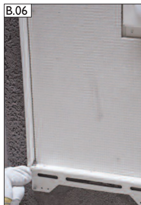
Pohled na spodní oblast závěsu dvířek s ochranným těsněním odříznutým na místě v oblasti závěsu dvířek.
