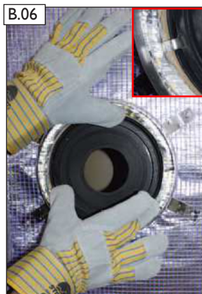
Zatlačte do otvoru adaptér až po ocelové hrany.
