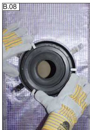
Externí adaptér s mazivem naneseným na okraj, vložte do omítkového kroužku.
