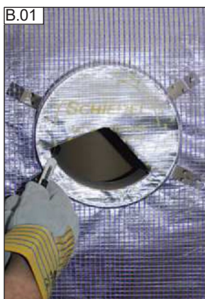
Speciální hliníkovou fólii otevřete řezacím nožem na vyznačené čáře.
