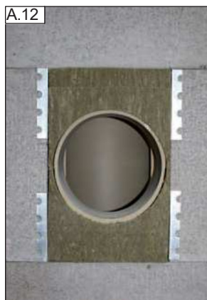
Pohled zepředu na připojení kouřovodu s čelní deskou.
