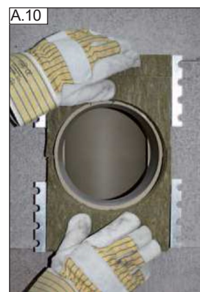
Nyní vložte čelní desku do otvoru ...
