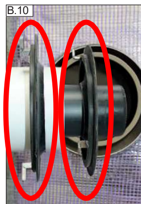
Při instalaci musí být kouřovod prostrčen oběma adaptéry.
