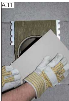
... a pomocí vyřezávací šablony přitlačte/vyrovnejte čelní desku s rovinou komínového tělesa.
