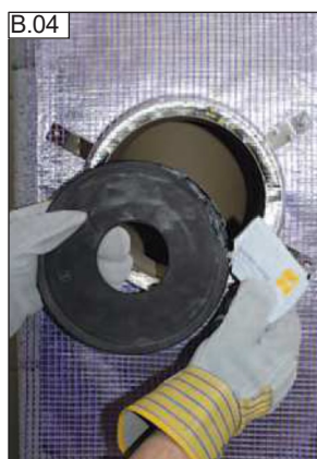
Okraje adaptéru namažte mazivem.
