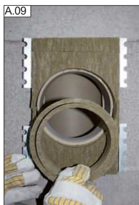
U průměrů 12-18 odstraňte vnitřní kroužky.
