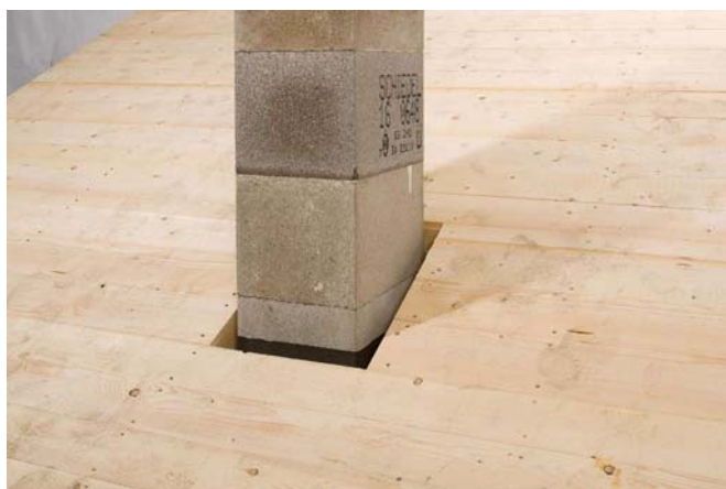
Prostup komínového tělesa střechou.
