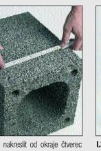
I.1 Do maltového lože položit hydroizolaci, na I.2 Na tvárnici nakreslit od okraje čtverec kou otvor dle nákresu vyříznout.
