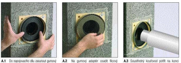
mazací pastou a zasunout. Spalinová část kouřovodu nesmí zasahovat do průduchu.
