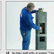
1.5 V další tvárnici vyříznout přes celou její 1.6 Otevřenou tvárnici osadit do maltového 1.7 Do maltového lože osadit plnou tvárni- 1.8 Na desku osadit vložku ze soupravy "T-kus keramická pata". Hadičku protáhnout otvorem v soklové desce.
