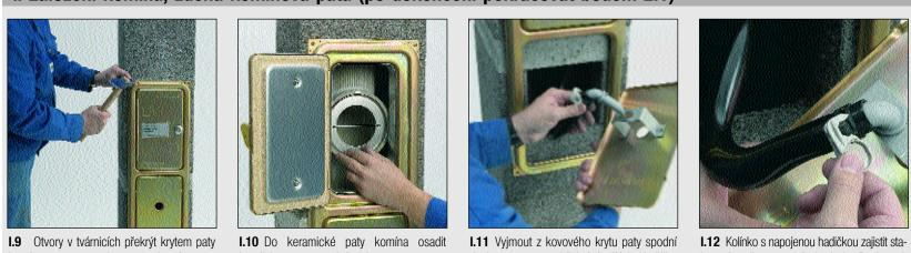
kroužek na vyrovnání tlaku ze soupravy desku s otvorem (překrývá sifón). Hadičku hovací spojkou a osadit do desky. Desku pak vrátit zpátky do krytu paty komína.
