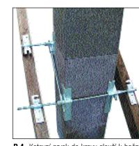
B.1 Okolo komína musí být v místě stropní B.2 Odstup od dřevěných konstrukcí musí B.3 Komín musí být zajištěn proti vybočení, B.4 Kotevní prvek do krovu slouží k bočnípřičemž průchody stropy a střechou lze počímu zajištění komína při průchodu krovem.
